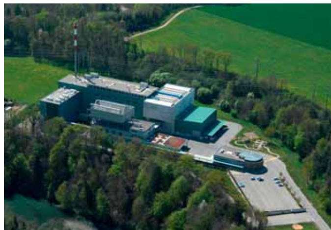
Fig. 4 L'usine d'incinération de SAIDEF SA, avec à l'extrême gauche l'installation pour l'incinération des boues de STEP (source: SAIDEF SA)
