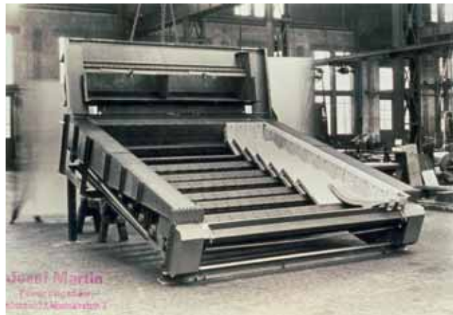
Abb. 6 Der MARTIN Rückschub-Rost in den 1930er Jahren
