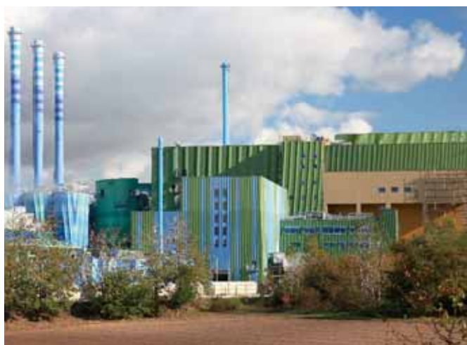
Abb. 6 ICFB Industriepark Hoechst: Aussenansicht vor der Inbetriebnahme 2010
