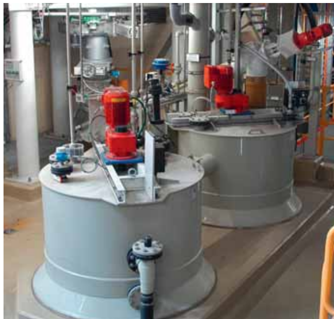
Abb. 6 Saure Flugascheextraktion in der KVA Trimmis.
